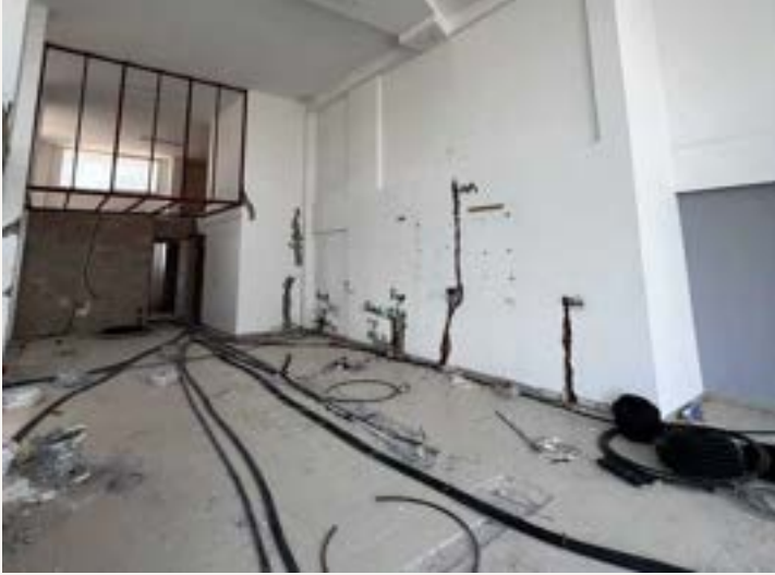
Devralınan mekanın mevcut durumu ve söküm süreci.
